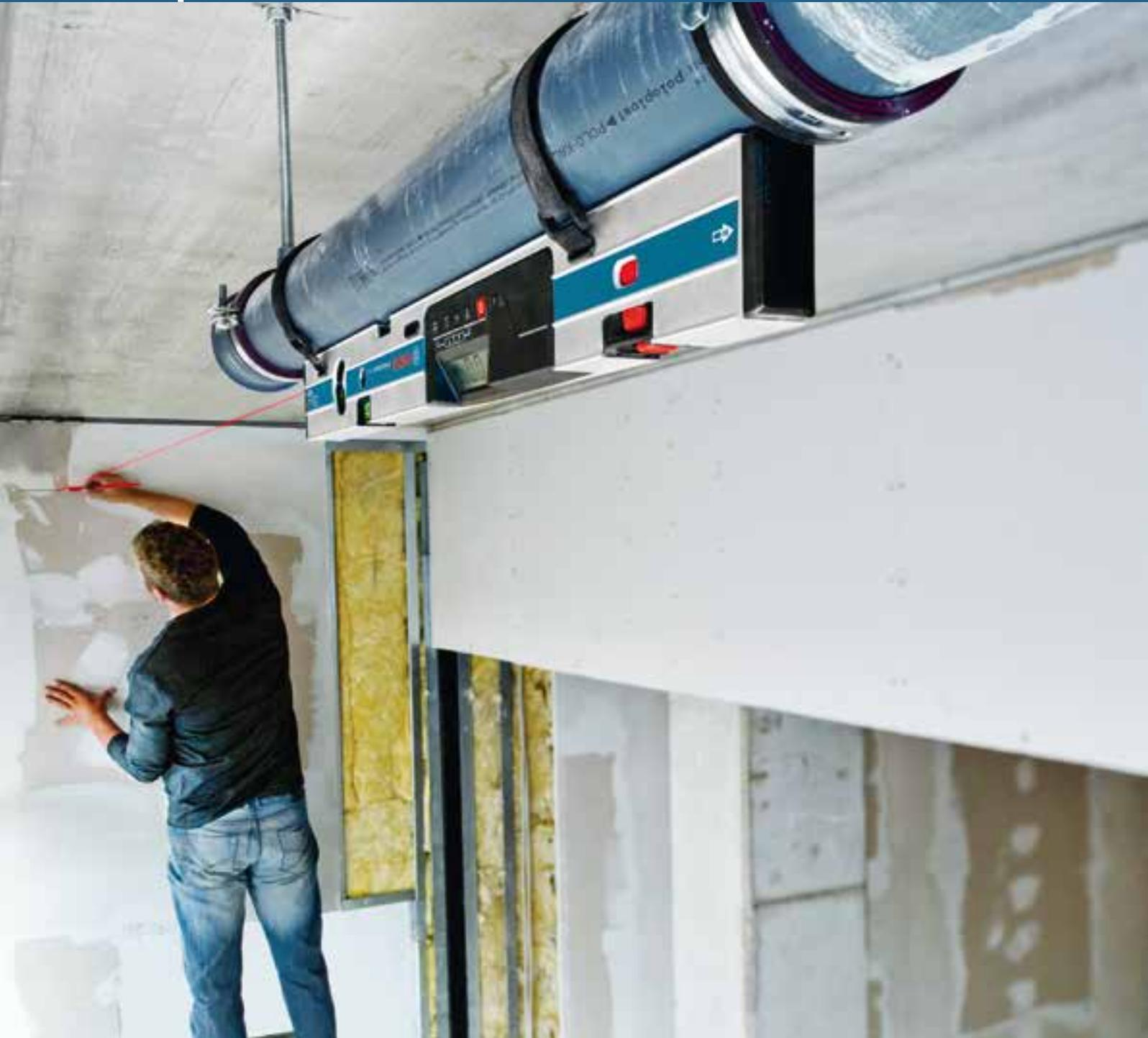
Ideal para la determinación exacta de inclinaciones, líneas horizontales o ángulos de 0° a 360°. En cualquier aplicación las herramientas convencer por su fácil manejo: señal acústica, funciones de memoria y de cálculo, así como pantallas legibles que facilitan el trabajo.
